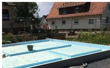
Die XPS-Wärmedämmung wird vollflächig verteilt und Vertiefungen werden direkt integriert und maßgenau vor Ort erstellt.
