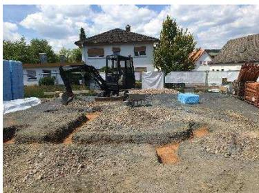
Die Baumaschine löst den Boden und erstellt Gruben für die Grundleitungen.
