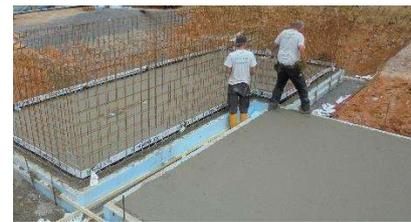
Anschließend wird die Konstruktion mit Beton verfüllt, sodass Stahl und Beton eine Einheit bilden. Nach der Trocknungszeit werden die Fundamente weiterverarbeitet.
