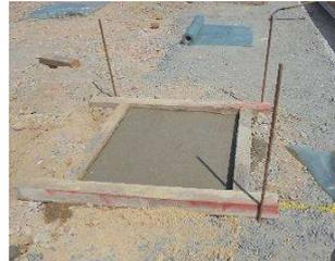
Im weiteren Verlauf werden Einzelfundamente ausgehoben und ebenfalls mit Beton verfüllt.
