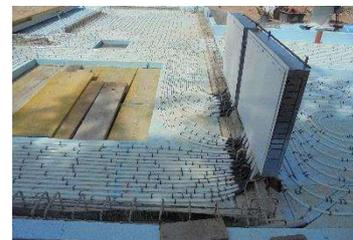
Nach grundlegenden Arbeiten wird zuerst der Heizkreisverteilerkasten positioniert und anschließend die Heizrohre mit Hilfe eines Heizplanes präzise verlegt.
