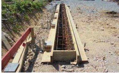
Mit Hilfe eines Schnurgerüsts und einer Fluchtschnur entsteht ein maßgenaues Streifenfundament. Dies wird bewehrt und mit Beton verfüllt.
