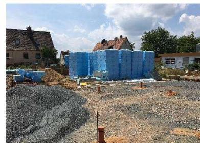
Nach Fertigstellung sind die Anschlüsse für den Bodenplattenbereich zu sehen.
