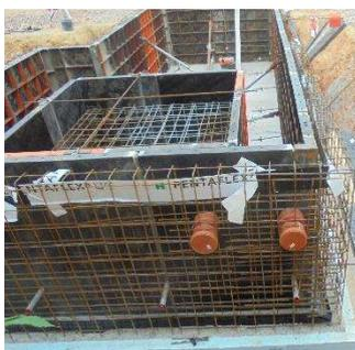
Die Wände der Technikgrube wurden eingeschalt und betoniert. Diese wurden mit einer umliegenden Dämmschicht wärmetechnisch verstärkt. Letztendlich wird eine Decke über der Technikgrube angebracht.
