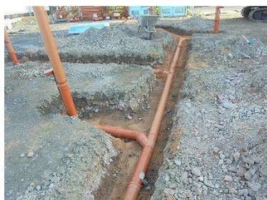
Nachdem diese verlegt und die Druckproben durchgeführt wurden, werden die Gruben mit Sand verfüllt.
